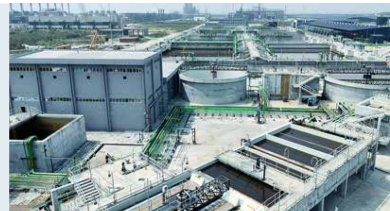
Wasseraufbereitung für Ölraffinerie DANGOTE, Nigeria: 110.040 m³/d inkl. SBR, UF, RO und RO Reject treatment
