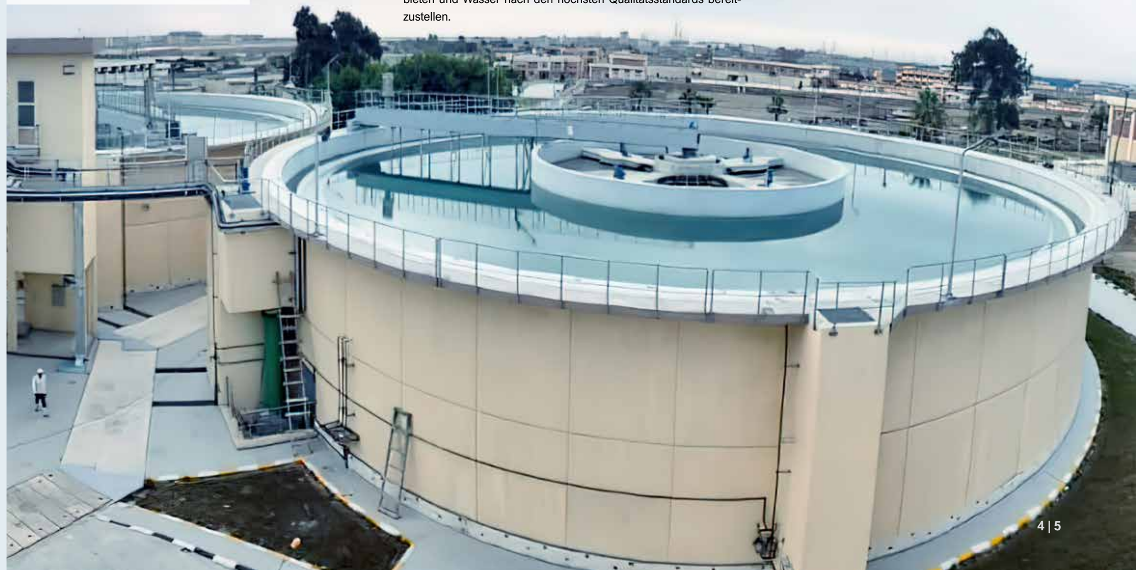
El Raswa WTP II, Port Said, Ägypten: Multi-Barrieren-System für Nilwasser, 80.000 m 3 /d.
