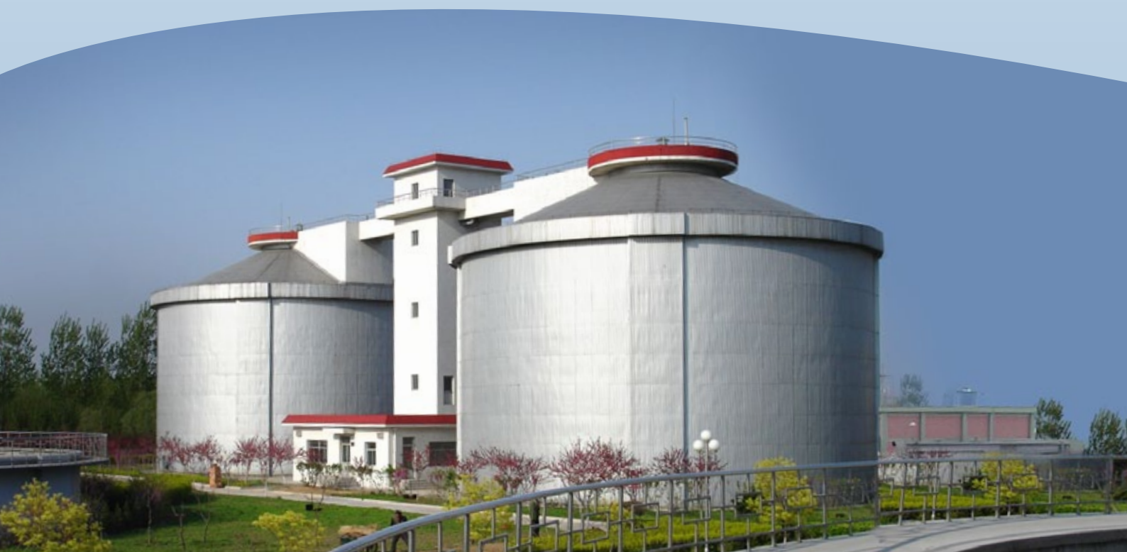
Klassischer Faulbehälter (Kläranlage Weifang, V.R. China, 100.000 m³/d)
