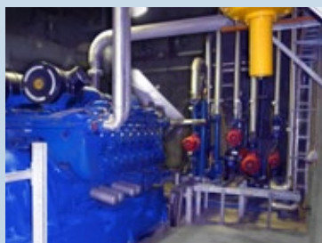
Blockheizkraftwerk
